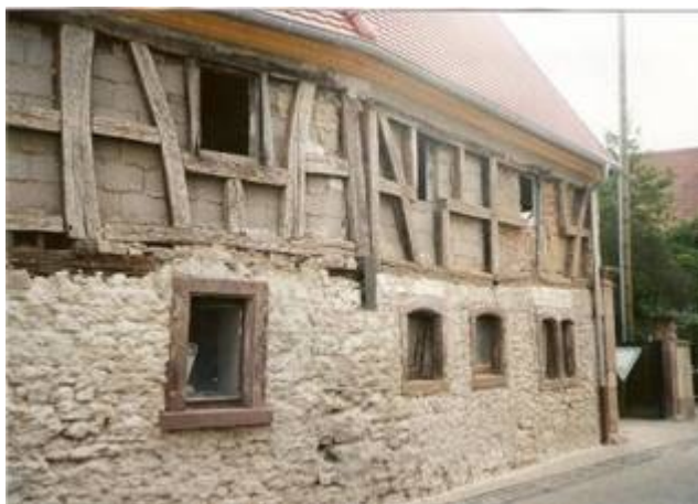
Haus 17 / 19 nach der Entkernung
